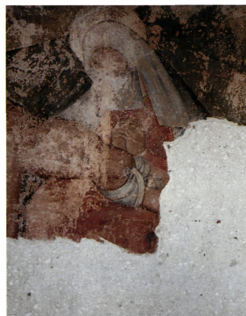
Pieta uit de crypte van Sint-Baafskathedraal te Gent, waarbij onderaan de bovenlaag is afgevallen en de onderste ruwe kalkbepleistering zichtbaar wordt (foto M. Buyle)
