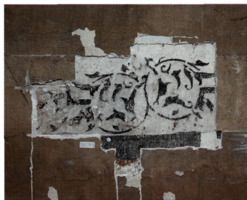
Sonderingsproef naar onderliggende beschildering in het transept van de Onze-Lieve-Vrouwekathedraal te Antwerpen (foto M. Buyle)
