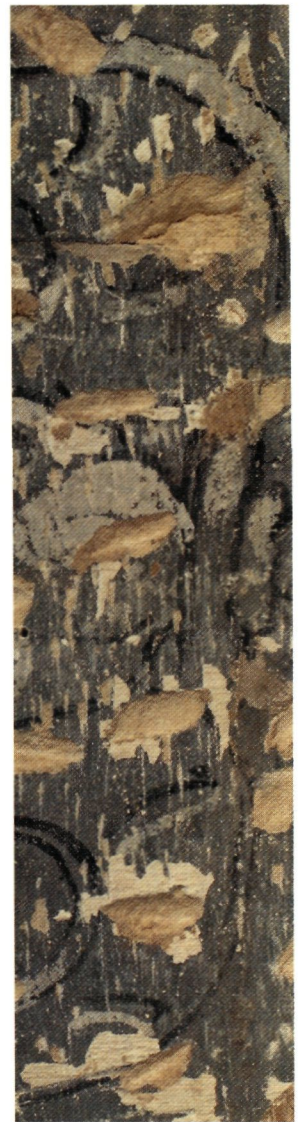
Bij het aanbrengen van een nieuwe bepleistering werd vaak de vorige laag ingekapt voor een betere hechting, hier op een fragment uit het kasteel Vilain XIII te Leut (foto M. Buyle)
