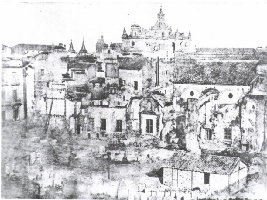
Figura 1. Histórica fotografía del derribo del convento casa grande de San Francisco de Sevilla en 1841. Foto: Francisco de Leygonier.
