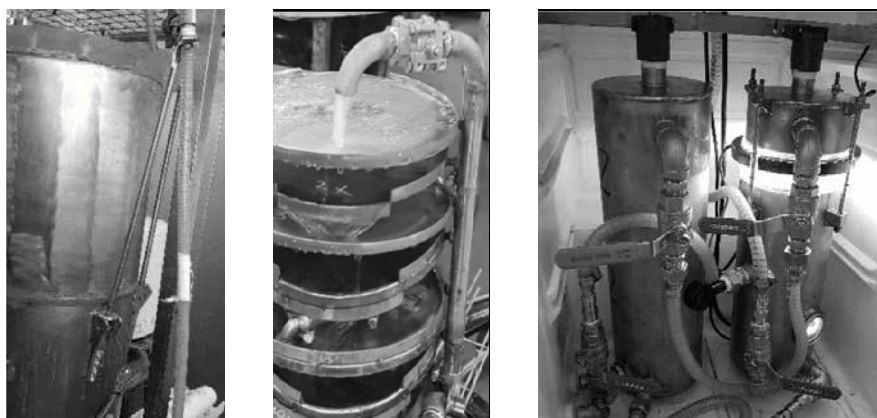
Figura 2. Detalles de: a) Reactor; b) Platos de evaporación; c) Borbotadores de \text{NH}_3
