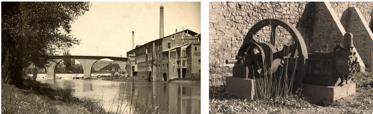
Imatge 1. Fàbrica de les culleres i generador de corrent de la mateixa
