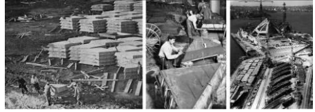
Figura 8: Pier Luigi Nervi. Elementos prefabricados del Palazzetto dello Sport, 1958-1959. Jørn Utzon. Prefabricación de los paneles de la cubierta de la Ópera de Sídney, 1956-1963
