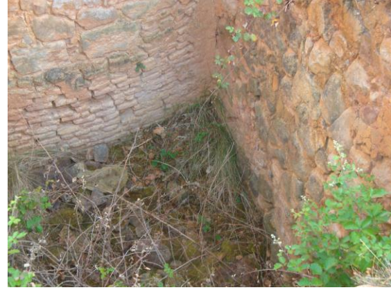
FOTOGRAFÍA 12 Interior del tejar
