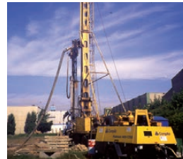
Equipo de perforación de un sondeo
