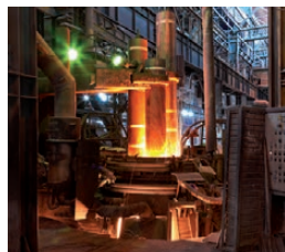
Horno de fundición eléctrico
