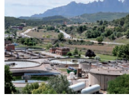
Depuradora de aguas
