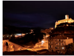
Iluminación con lámparas de vapor de sodio (Manresa)
