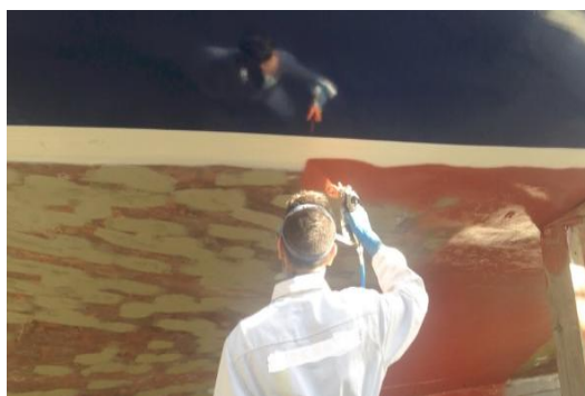
Figura 24. Aplicació de pintura amb pistola. - Font: Tecover
