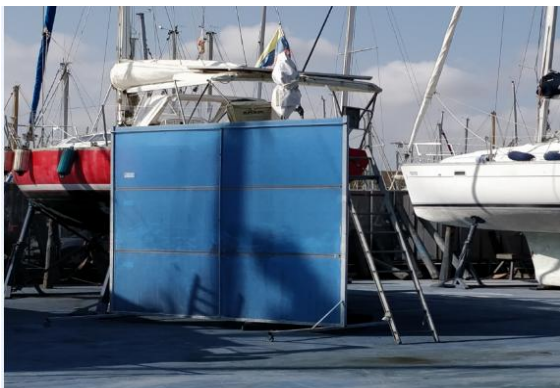
Figura 74. Pareds de protecció de pintura. – Font: pròpia
