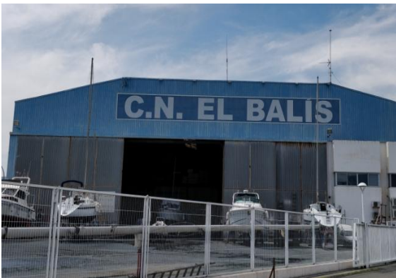
Figura 49. Hangar cobert de l'escar. - Font: pròpia
