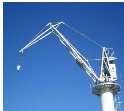
Figura 12. Grúa "pico-pato". - Font: Ingenierías Técnicas Portuarias
