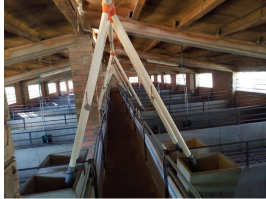
Figura 8. Sistema d'alimentació automàtic
