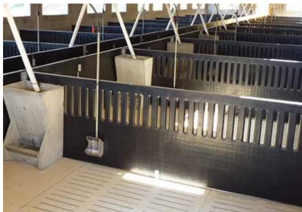
Figura 22. Mur parcial de polipropilè
