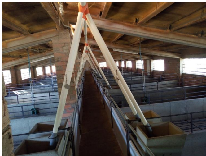
Figura 25. Sistema d'alimentació automàtic.
