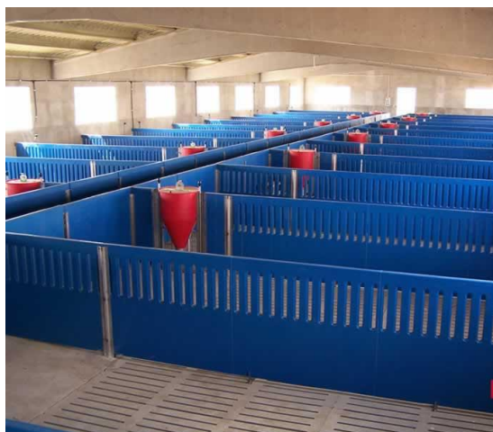
Figura 18. Laterals i frontals de polipropilè
