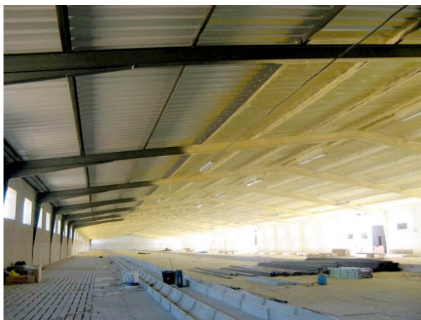
Figura 11. Estructura metàl·lica d'acer de perfil IPE
