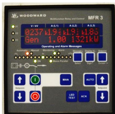
il·lustració 37 Multi Controlador (Relay) Woodward MFR3, connectat a xarxa.
