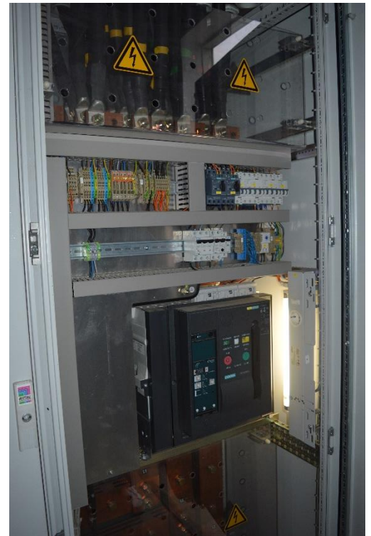
il·lustració 39 Interruptors automàtics (Switchgear)
