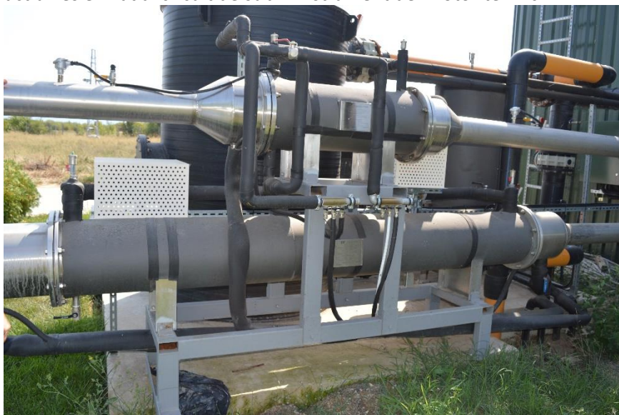
il·lustració 14 Circuit calent a baix, circuit fred a dalt.
