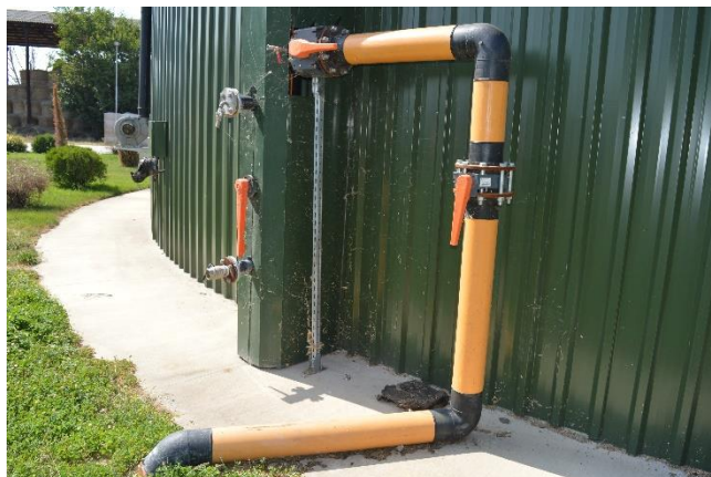
il·lustració 10 Sortida biogàs digestor, vàlvules antiretorn.
