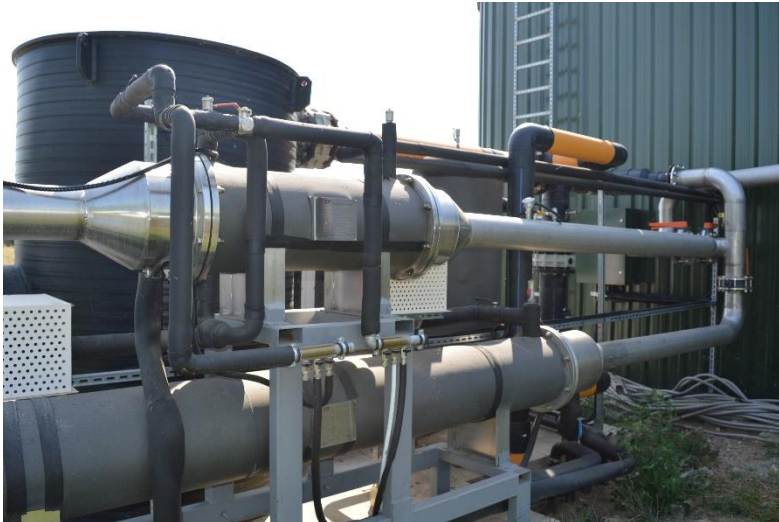
il·lustració 16 Filtre de carboni actiu, a l'esquerra tubular, a la dreta càmera de màquines.
