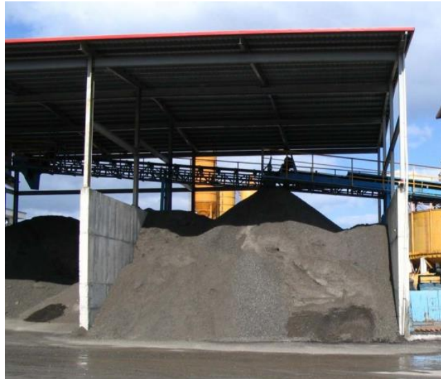
Fig. 2.16 Acopio del RAP bajo techo (Brock y Richmond, 2007).
