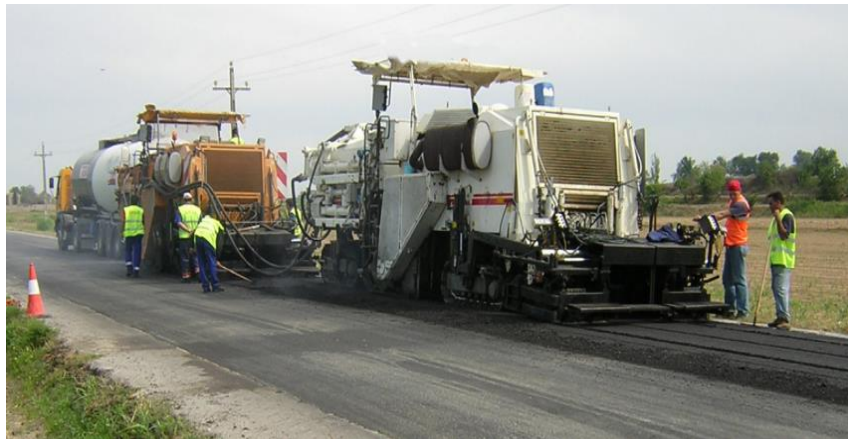
Fig. 2.5 Equipo para llevar a cabo el reciclado de frío con emulsión (CEPSA, 2008).
