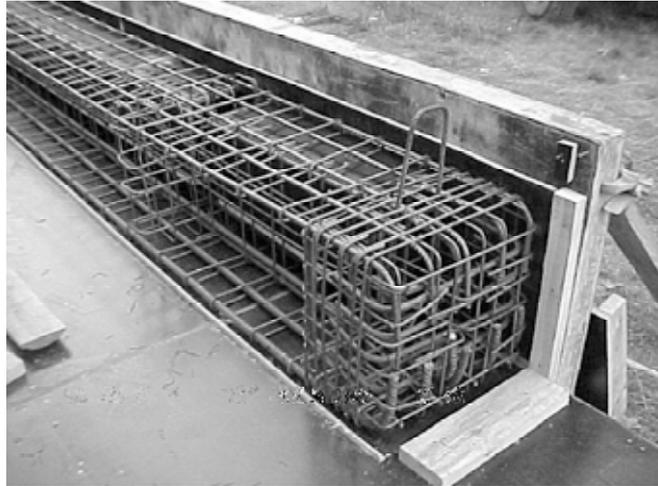
Figura 8. Armado de la viga V1-PC.
