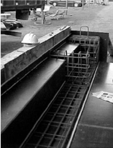
Figura 7. Armado de la viga V1-SFRC.
