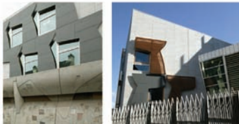
Parlamento de Escocia. Ventanas y aplacados del Edificio Canongate y Torre anexa
