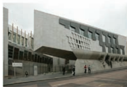
Figura 10. Edificio y muro Canongate
