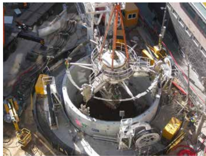
▲ Pozo vertical en la C/Enric Granados para el Tren de Alta Velocidad (AVE) en Barcelona (España). Cortesía: SACYR Construcción, S.A.
