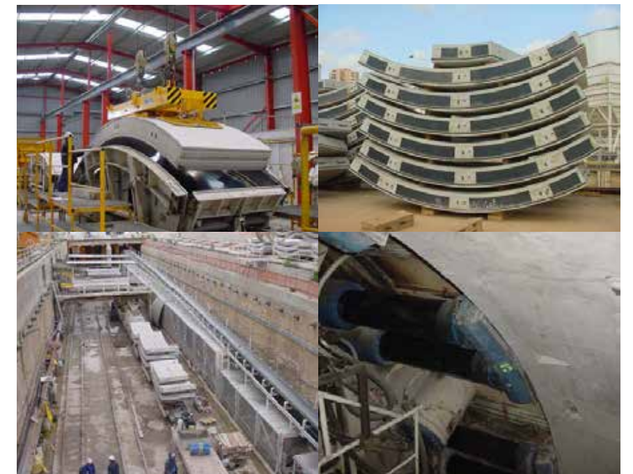
▲ Figura 1. Situaciones transitorias de carga: (a) desmoldeo; (b) acopio; (c) transporte y (d) colocación.
