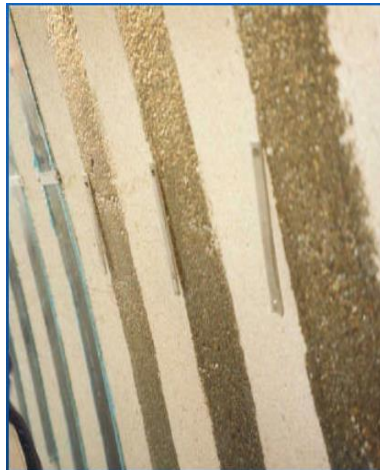
Il·lustració 2-7. Imprimación epoxi
