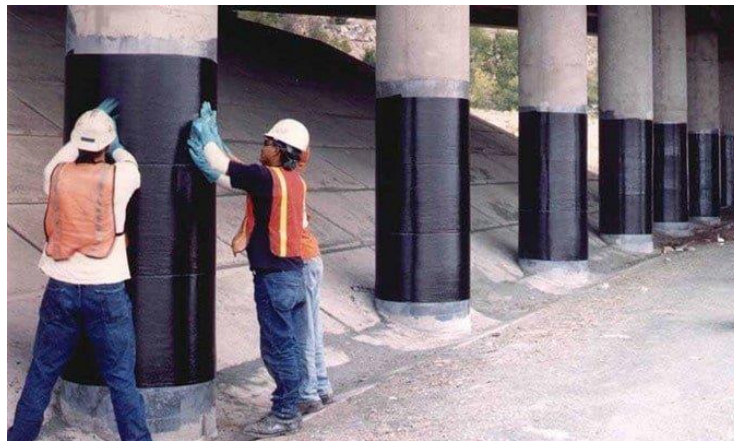
Ilustración 2-4. Refuerzo de pilares con FRP
