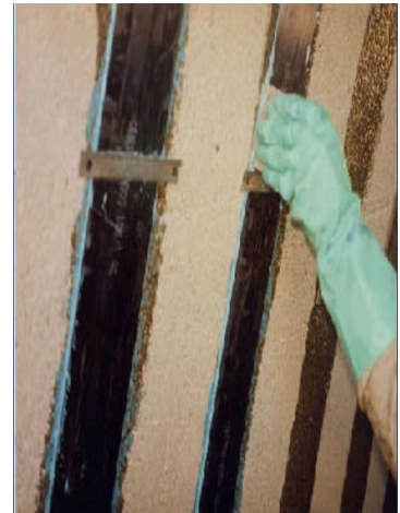
Il·lustració 2-6. Presión y apoyo local
