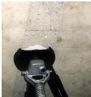
Ilustración 2-5. Limpieza por abrasión
