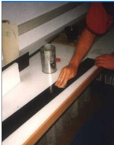
Il·lustració 2-8. Limpieza de la superficie
