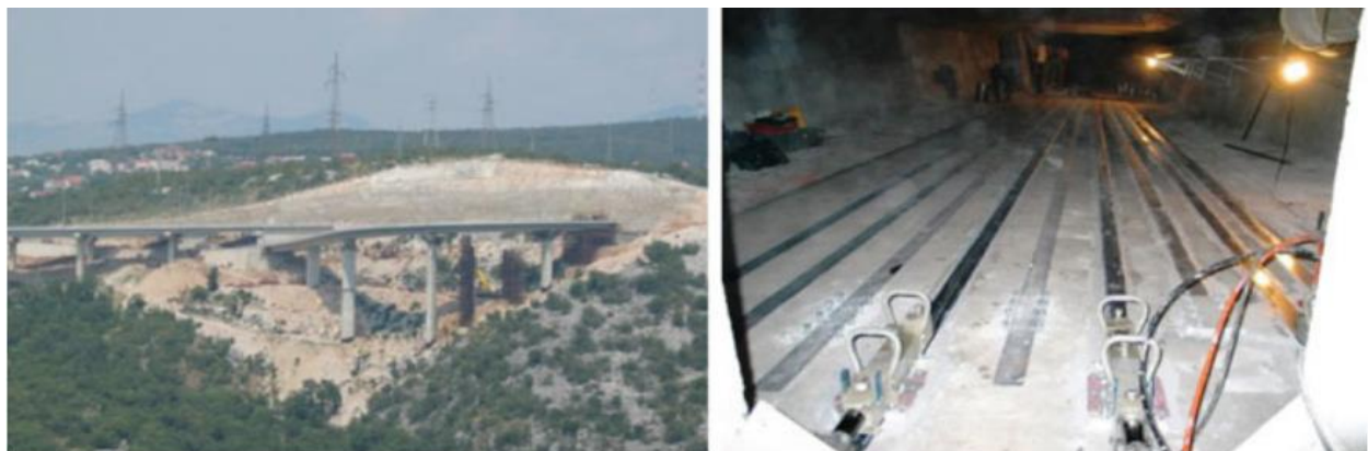
Ilustración 2-13. Ejemplo de pretensado de un puente en Rijeka, Croacia.
