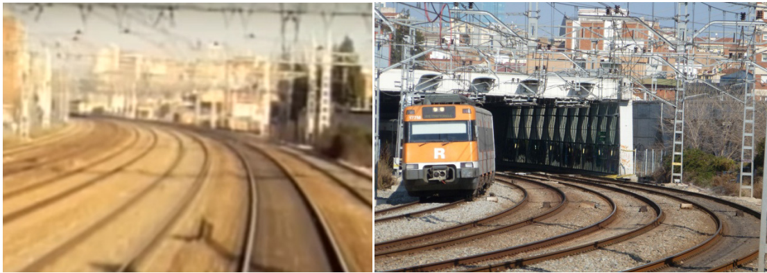
Figura 16: Reducció del nombre de vies a l'entrada de Sants. De 6 vies el 1993 (esquerra) a 4 vies actualment (dreta). Fonts: Youtube (esquerra), Flickr (dreta).
