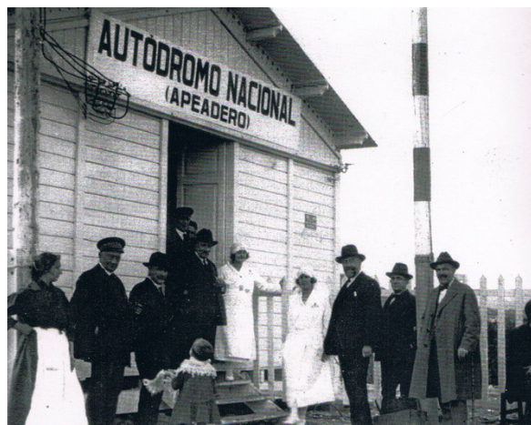
Figura 4: Baixador de l'Autòdrom de Terramar, utilitzat només pel gran premi d'Espanya de 1923. Font: Lunweg, 2006. El 1891 es fusionen TBF i MZA (Madrid-Zaragoza-Alicante), conservant el nom de la segona.
