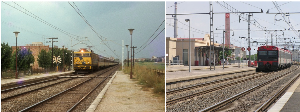
Figura 6: estació de Cunit abans de les obres dels anys 80 (esquerra) i després (dreta).
