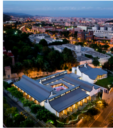
Figura 3.3 Imagen del exterior de la Casa dels Xuklis
