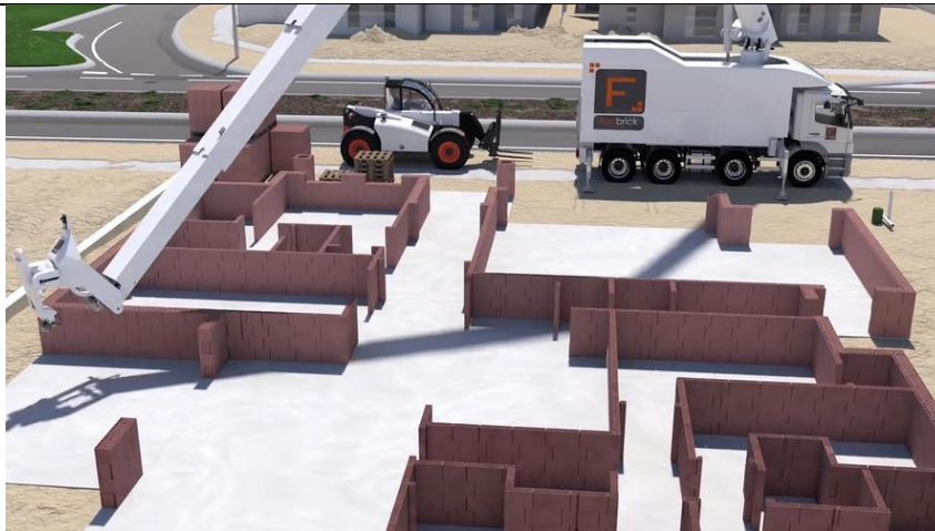
Imatge 4.11. Concepte 3D d'un Hadrian X executant murs. Font: website de Fast Brick Robotics Australia i Google Images.
