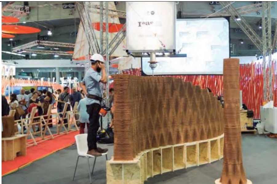
Imatge 4.49. Estructura fabricada pel robot CoGiro a la Fira Construmat de Barcelona, al Maig de 2017. Font: website de la Fira Construmat de Barcelona.
