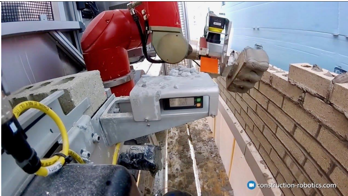
Imatge 4.7. SAM en execució d'un mur de blocs prefabricats de formigó. Font: website de Construction Robotics.
