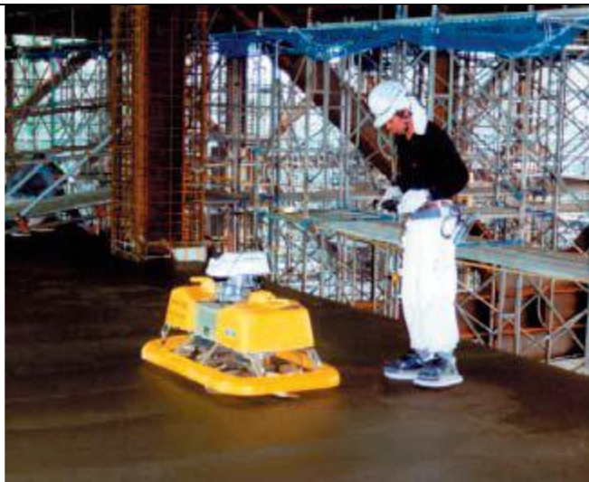
Imatge 4.32. Imatge del Robocon, la següent generació de robots d'acabat de formigó desenvolupat per Tokimec Construction. Font: Google Images.
