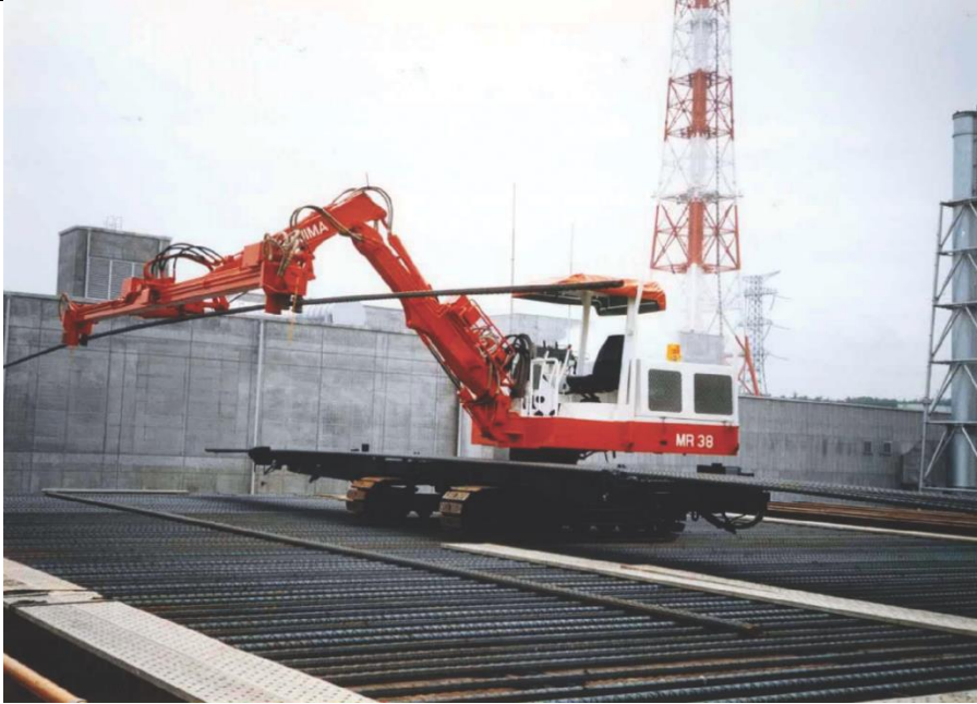
Imatge 4.19. Robot de posicionament de barres d'acer pesades MR38, per a l'armat del formigó, en procés de col·locar un seguit de barres en el seu lloc corresponent abans de formigonar. Font: Kajima Corporation.
