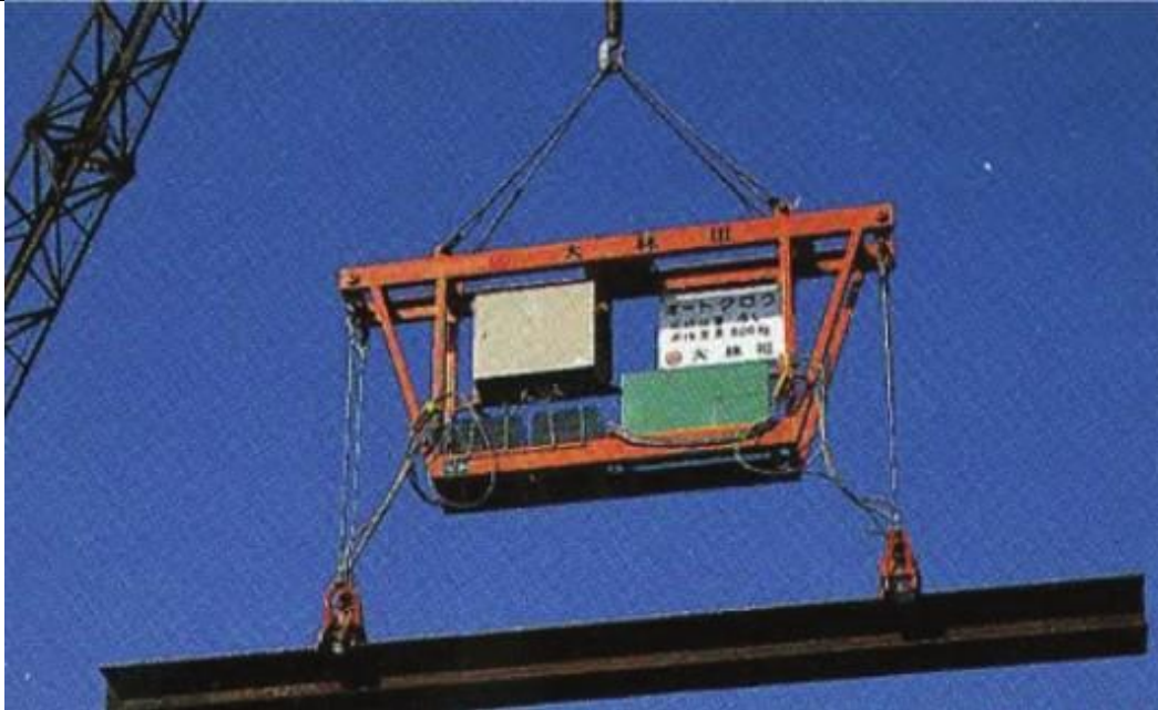
Imatge 4.23. Imatge de l'Auto-Claw instal·lat a una grua i procedint a la col·locació d'una biga per a estructura metàl·lica. Font: Construction robots: elementary technologies and single-task construction robots.
