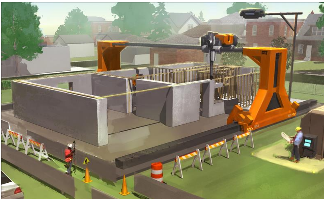
Imatges 4.25 i 4.26. Conceptes en 3D del Gantry-Type Contour Crafting. Usable tan en construcció on-site com per prefabricació, és un mètode molt interessant de treballar amb formigó. Font: Google Images.
