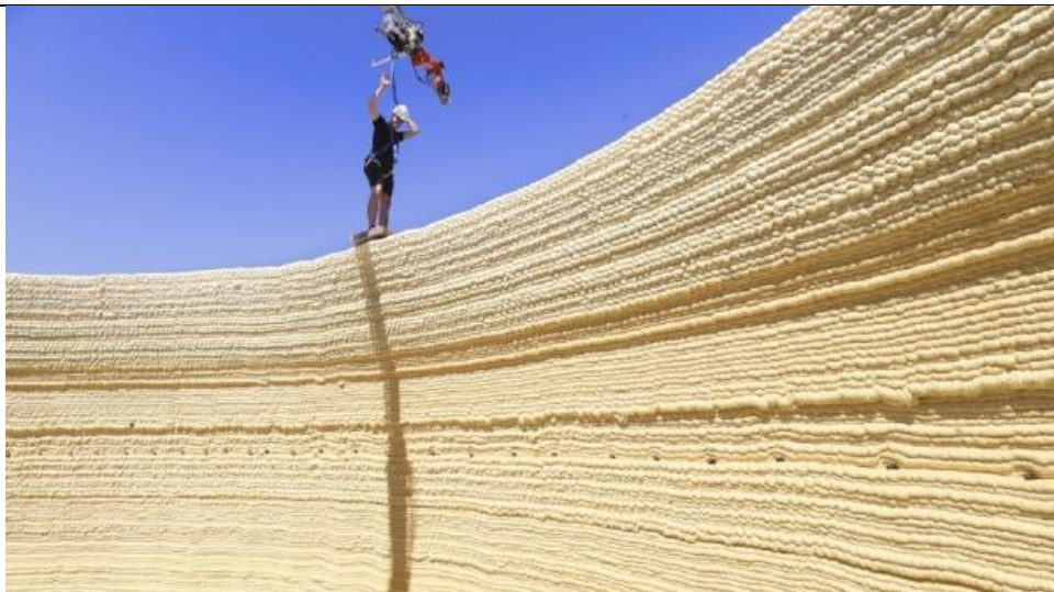
Imatge 4.40. Cúpula oberta d'escuma feta amb el DCP, de 14,6 metres de diàmetre i 3,7 metres d'alçada. Font: website de la CBC News, Technology and Science. Font: CBC News, Technology and Science.
