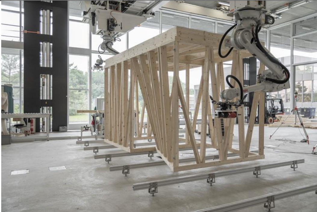
Imatge 4.43. Estructura de fusta del pis superior de la DFAB House, a Zurich, construïda robòticament. Font: website del grup de recerca de Gramazio i Kohler.
