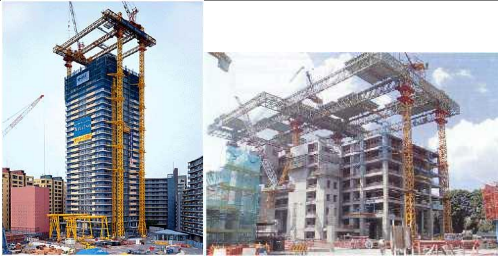
Imatge 4.13. Vistes exteriors de la construcció de dos edificis diferents amb el New SMART System. Es pot observar les columnes de suport i la plataforma superior de construcció. Font: website de Shimizu Corporation.
