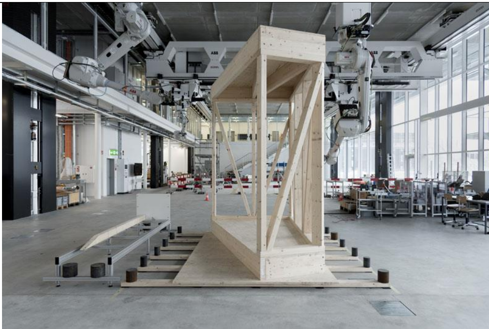
Imatge 4.44. Una altra vista de l'estructura de fusta per a la DFAB House. S'observen els rails del sostre per on es desplacen els braços robòtics. Font: website del grup de recerca de Gramazio i Kohler.
