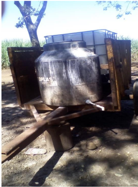
Figura 27. Instalación de tanque de depósito (300 L). Fuente: Julian Chun (2017).
