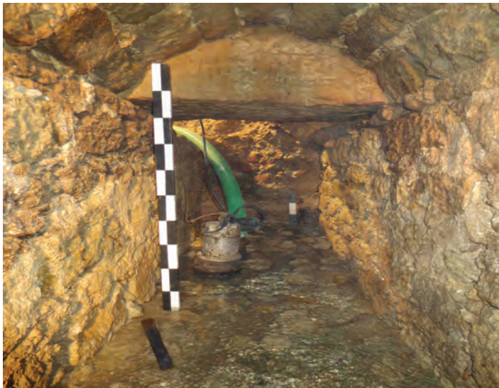
Fig. 12 Aspetto do interior da cloaca (perspetiva Sul-Norte), com os vestígios de cofragem perdida em madeira ao fundo, junto à escala de menor dimensão (Arquivo CAL).
