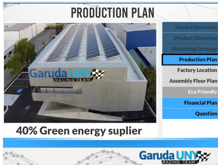
Gambar 38. Pemasangan Panel Surya Pada Atap Perusahaan
