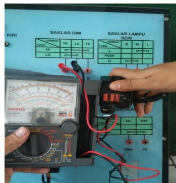
Gambar 31. Pengujian Kontinuitas Dimmer Switch posisi low (18-11-2017)
