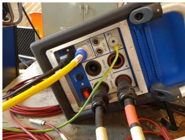
Figura 3.18 – Conexão do CPC 100 com o primário do TC.
