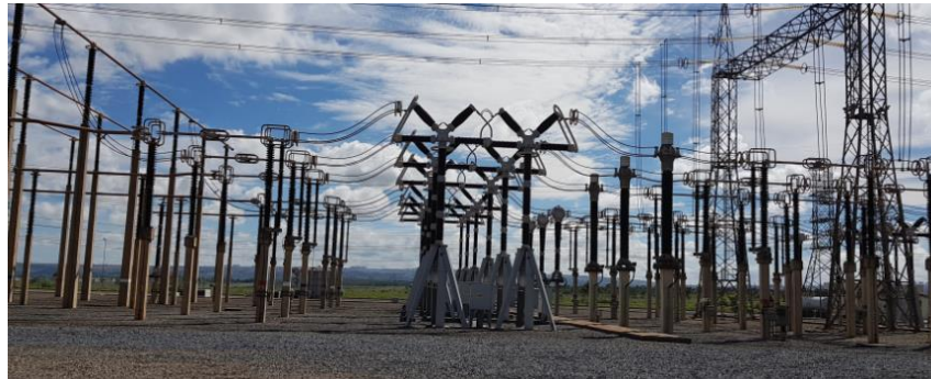
Figura 1.1 – Linha de Transmissão de 500kV da Subestação Samambaia - DF.
