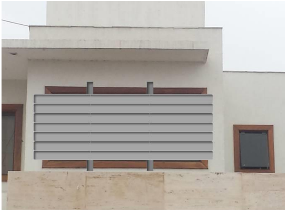
Figura 05 – Simulação de instalação do Brise Metálico Retrátil
