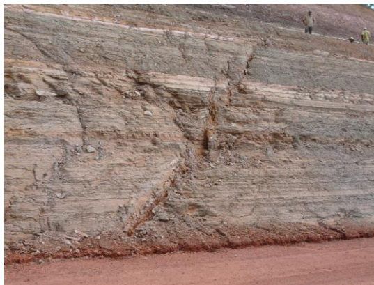
Figura 4. Vista do talude do Corte 23.
