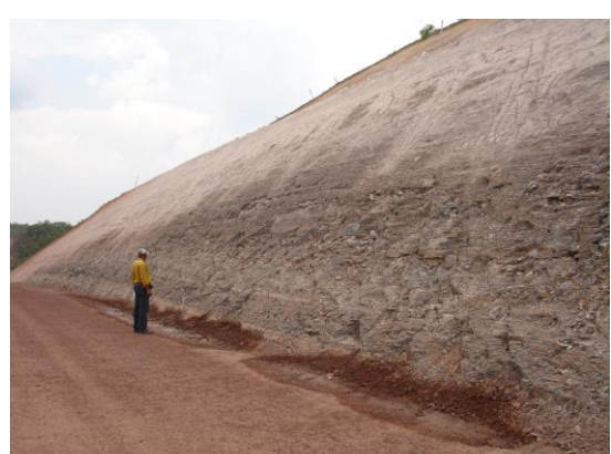
Figura 13. Corte 31 (saturação da base do talude).
