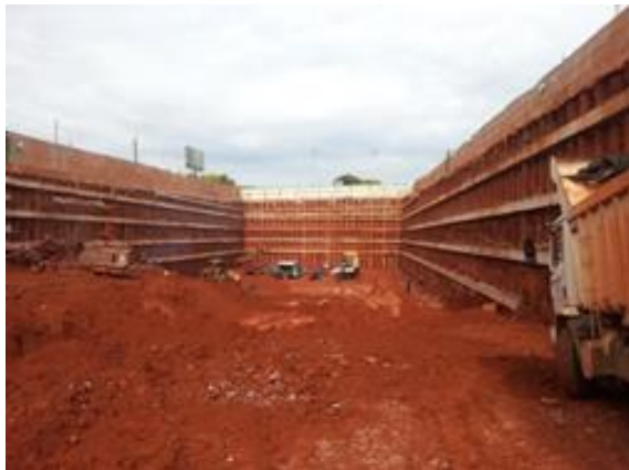
Figura 2. Exemplo de parede em estaca escavada.
