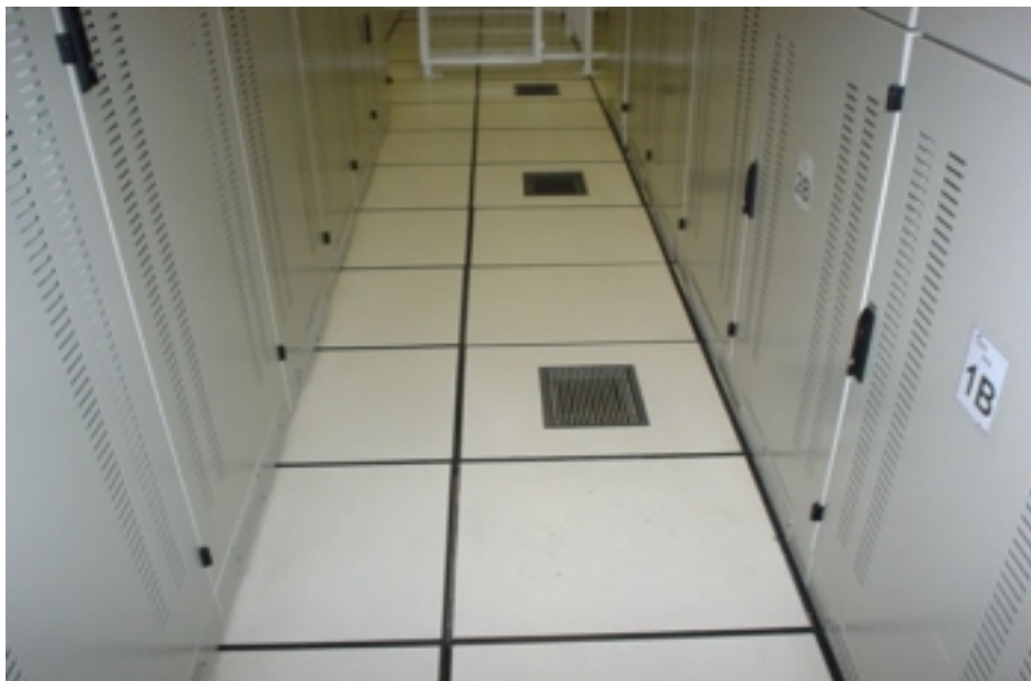
Figura 5: Pisos elevados com saídas de ar frio e Racks para alocação dos servidores no DC da Osasco Telecom/Intelig
