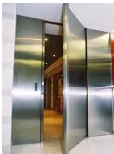
Figura 4: Portas de aço para acesso ao DC da .comDominio em São Paulo
