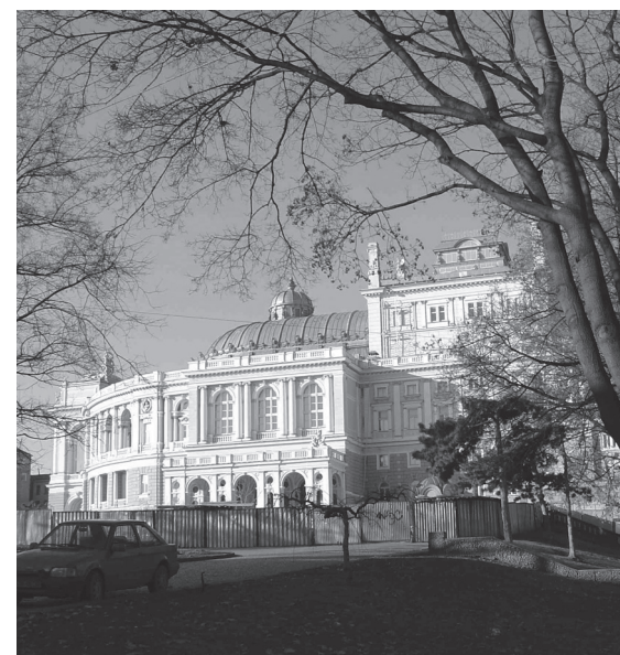
Figuur 3 operagebouw Odessa
