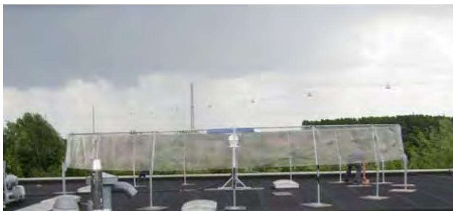
Figur 6.5.1.a Vejrradaren i Hvidovre placeret på et tag med clutterfence rundt om radaren (DHI 2008)
