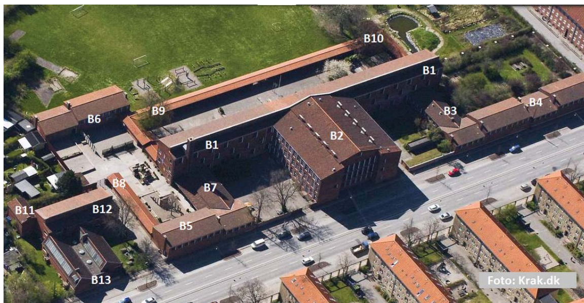
Foto 5: Luftfoto af Ellebjerghøj Skole og bygningsbetegnelser ifølge entreprenørens etapeplan
