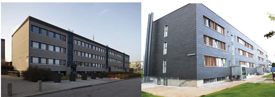
Foto 2: Klimablokken før og efter renoveringen
