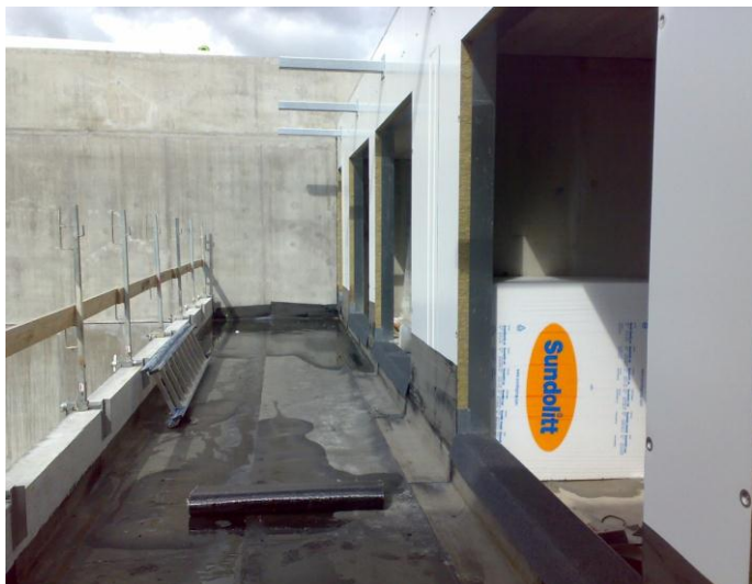
Billede 14: Tagpap er ved at blive brændt ind i vindueshullerne [23. juni 2008].
