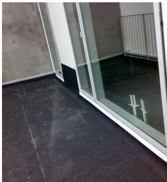
Billede 17: Tagterrasse med tagpap, Paroc og vinduer [6. august 2008].
