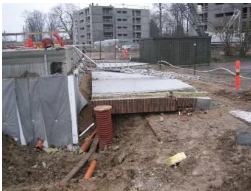
Billede 3: De to gavlelementerne vælter til jorden.
