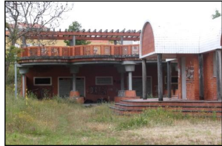
Foto 11 - Construção sem uso. As portas e janelas encontram-se emparedadas. Lugar de dormida dos sem-abrigo.
