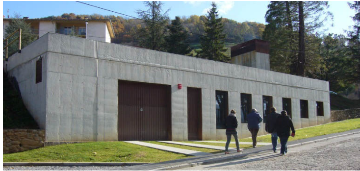
Figura 20. Instal·lacions de les calderes de biomassa Ribes de Freser. Font: Elaboració pròpia.
