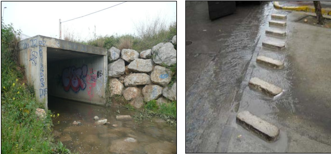
Figura 3.6: Fotografies del sistema de gestió hídric a Sitges. Esquerra: sortida de la canonada d'aigües pluvials; Dreta: pedestals situats als vials del casc antic per permetre el desplaçament dels vianants durant períodes de pluja. (Font: Elaboració pròpia).
