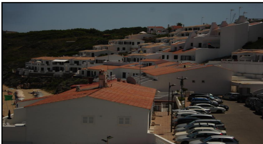
Figura 2.2: Nucli turístic d'Arenal d'en Castell on s'observa la construcció a peu de platja. Font: elaboració pròpia, 2010
