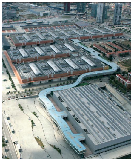
Figura 2.6: Instal·lació de les plaques fotovoltaiques a la fira de Barcelona. Font: ICAEN, 2009.
