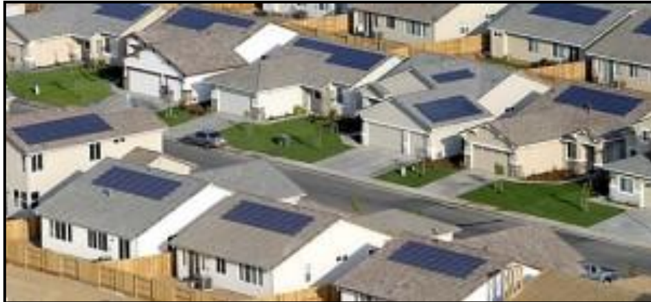
Figura 2.5: Instal·lació solar fotovoltaica connectada a la xarxa elèctrica. Font: web www.lescale.es , 2010.
