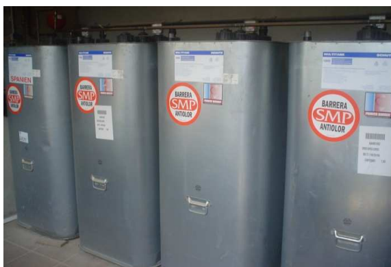
Imatge 7-6: Dipòsits de gasoil Font: Elaboració pròpia
