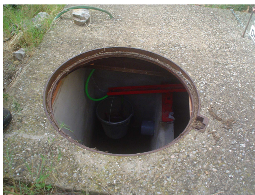
Imatge 7-1: Mecanisme de separació d'aigua de pluja. Font: Elaboració pròpia
