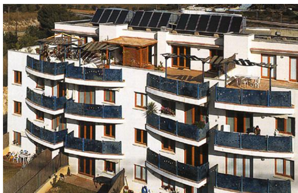
Figura 1. 15: Imagen del edificio Els Molins. Fuente: Solarge (www.solarge.org)
