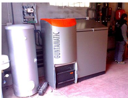
Figura 1. 22: Caldera de pellets en el Garraf. Fuente: www.soliclma
