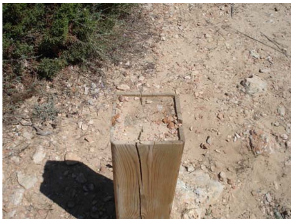
Figura VI.3. Exemple de desperfectes en una de les fites. Font: Elaboració pròpia.
