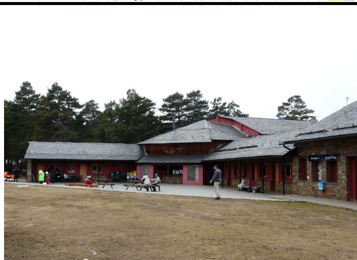
Vista general del refugi.
