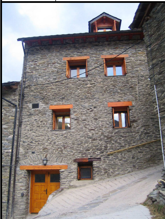
Vista general del refugi.
