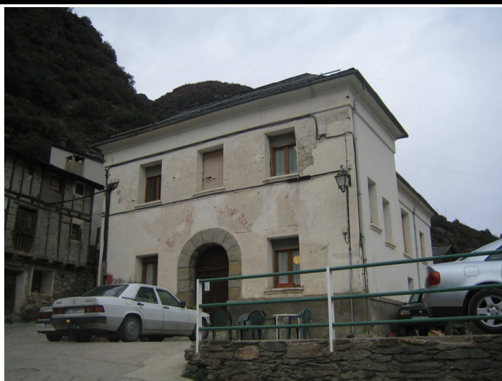
Vista general del refugi.
