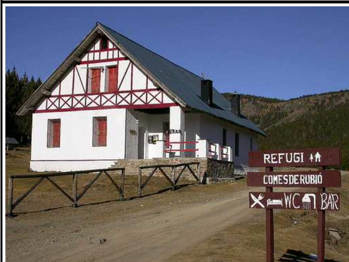
Vista general del refugi i la seva entrada.
