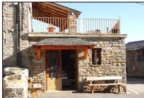
Fotografia 7: Detall de la façana de la Pensió Can Trilla. Font: Elaboració pròpia
