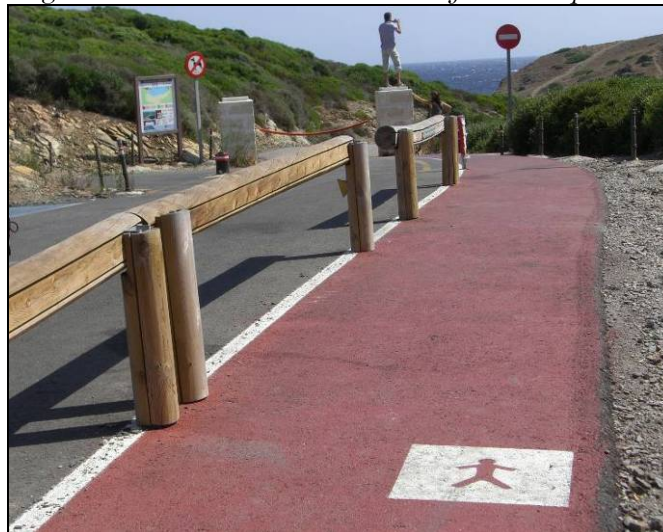
Imatge 16.64 Delimitació dels accessos al final de l'aparcament.
