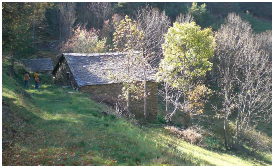
Imatge 1: Vista general de la borda en el seu entorn
