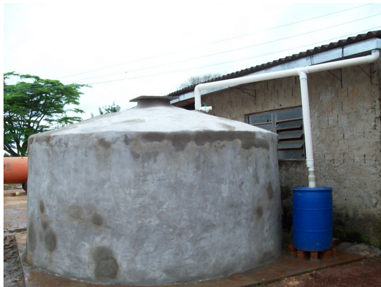
Figura 2: Cisterna de ferrocimento com sistema de descarte (tambor azul) e calha construídos no assentamento Fazenda Pirituba 2, na COPAVA
