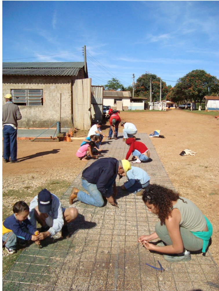
Figura 1: Agricultores e crianças participando da montagem da estrutura para cisterna de ferrocimento
