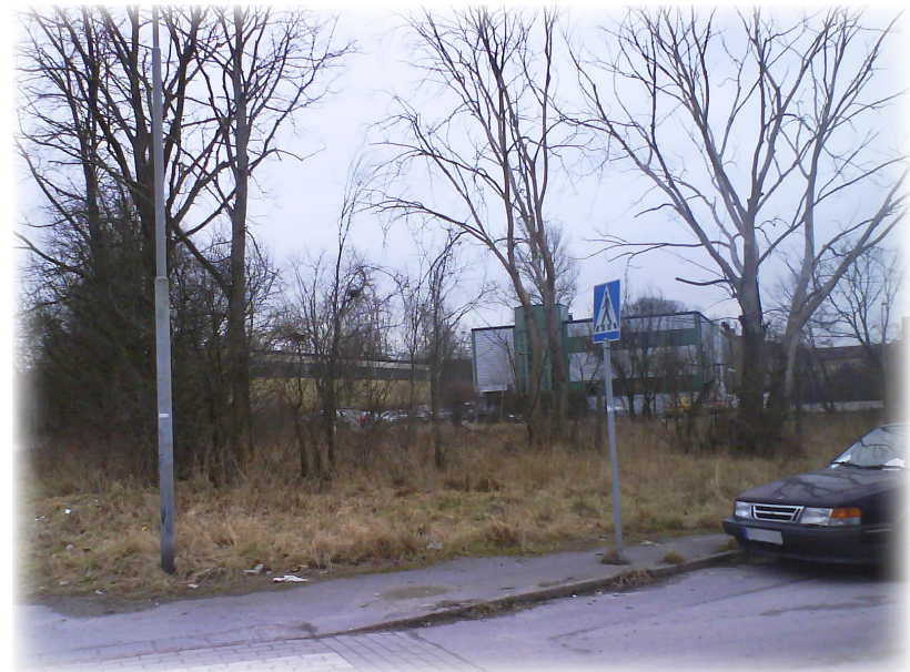
Figur 63. Området sett från norr vid cykeltunneln innan ombyggnationen.
