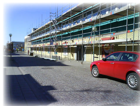
Figur 39. Hemköphusets baksida mot Strandvägen med pågående fasadbyte.
