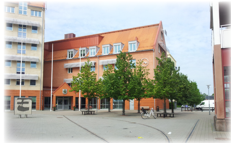
Figur 30. Det nya kommunhuset och torget framför.
