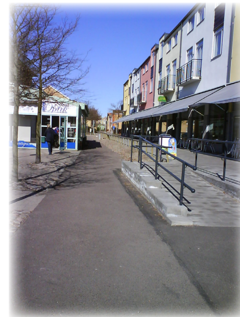
Figur 41. Stadsgata mellan det gamla centrumhuset och det första nybygget i centrala Lomma.
