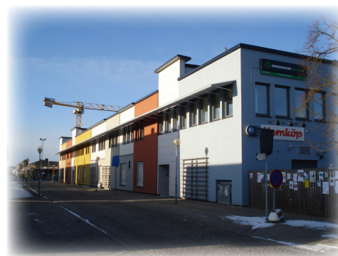
Figur 40. Hemköphusets nya fasad mot Strandvägen.
