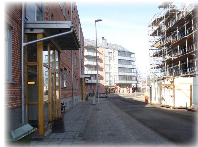
Figur 67. Gaturummet utmed Fabriksgatan.
