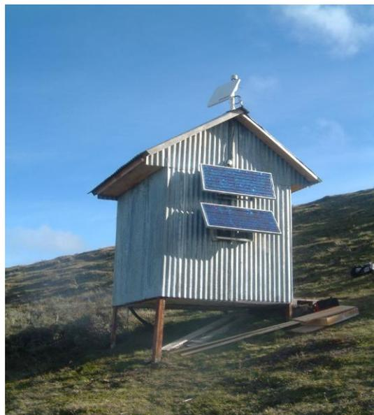
**Figura 6.9:** Estación DSPA. Izq: recinto del sensor. Der: recinto del sismógrafo y accesorios.
