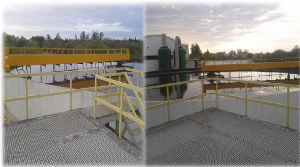
Figura 6-Decantadores Primários
