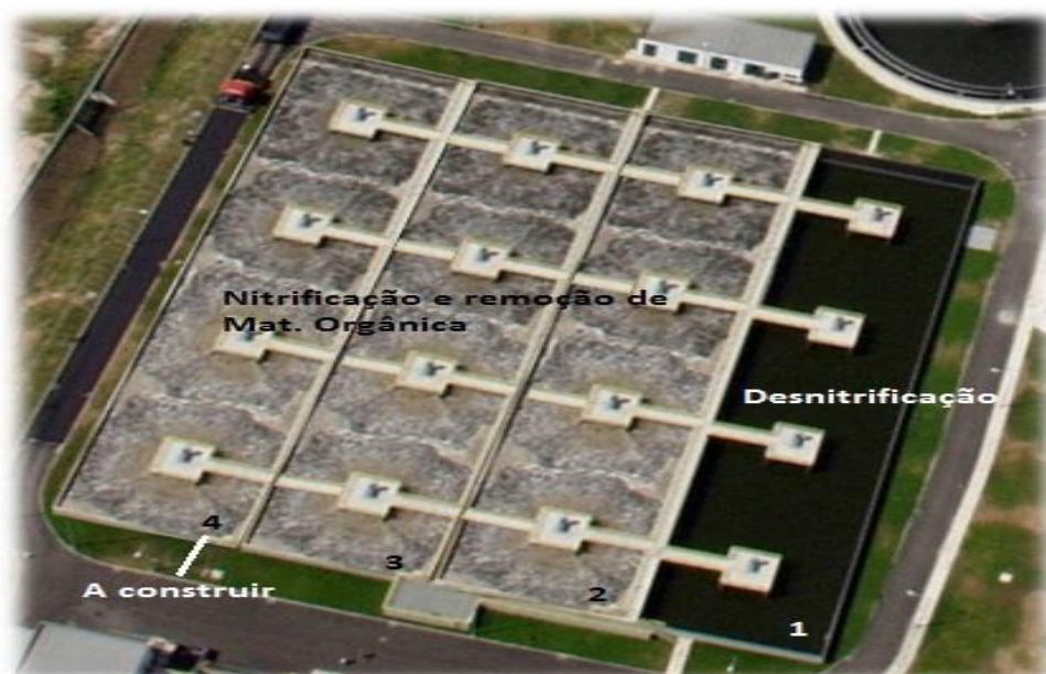
Figura 33-Solução proposta para nitrificação e desnitrificação
