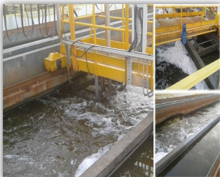
Figura 4-Desarenador e Desengordurador
