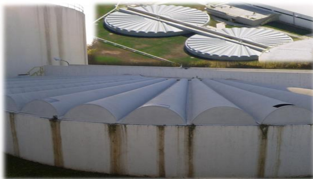
Figura 10-Espessadores Gravíticos de Lamas
