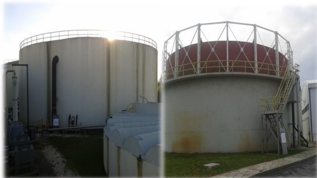
Figura 11-Digestores Primários e Secundário
