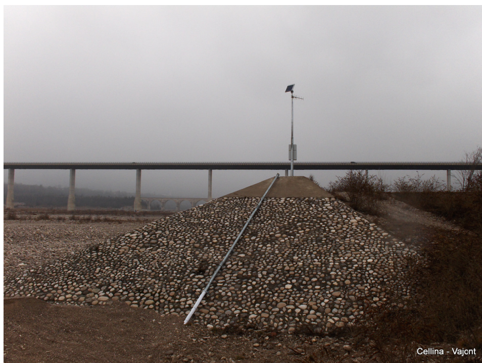
Figura 4.3: Piezometro per la misura idrometrica a Vajont sul t. Cellina
