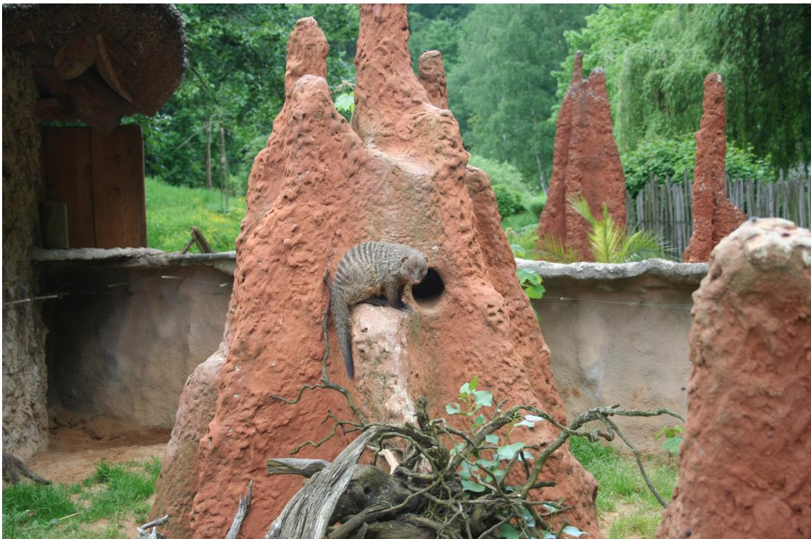
**Abb. 3:** Die künstlichen Termitenbauten. Sie bestehen aus Plastikboxen über welche eine Drahtkonstruktion gezogen ist. Das ganze Gebilde ist mit Zement überbezogen und rötlich gefärbt.
