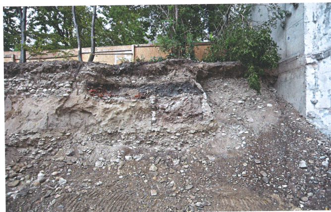
Abb. 40 Das spätmittelalterlich-frühneuzeitliche Kellerchen. Von links stösst das Fundament der Arealmauer an, über dem Keller liegt eine dunkle Schicht mit fabrikkzeitlichem Material, rechts anschliessend die verfüllte Baugrube des benachbarten grossen Einkaufsmagazins. Foto: Martin Block.
