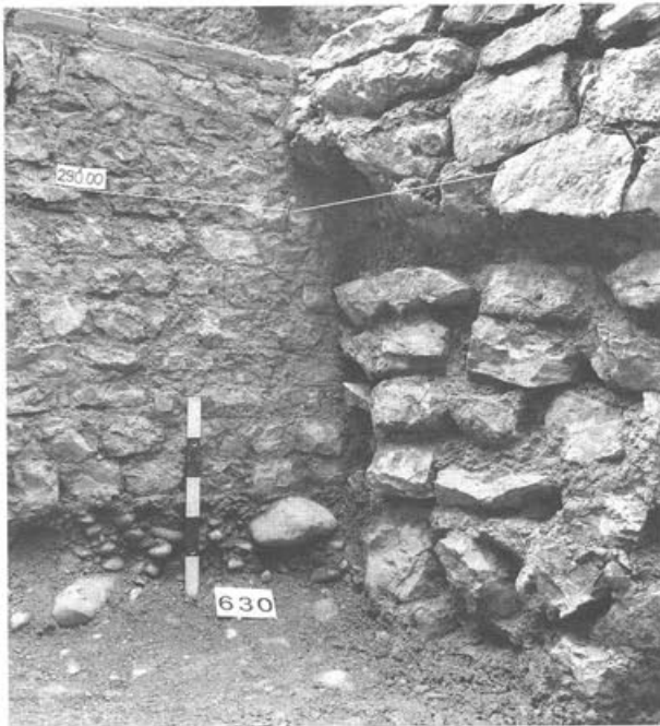
Abb. 21 Augst BL, Grabung 1990.51, Fläche 3. Stossfuge zwischen der älteren Kellermauer (MR 12) der Phasen 1 und 2 und dem jüngeren Fundament von Strebeifeiler 2 (MR 9) des 1. Theaters (Phase 4).
