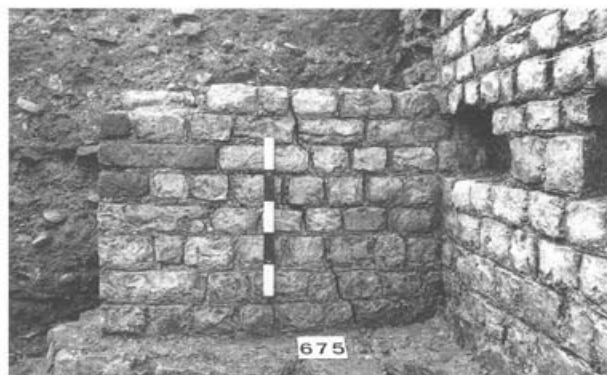
Abb. 34 Augst BL, Grabung 1990.51, Fläche 3. Blick auf die Nahtstelle zwischen der Umfassungsmauer (MR 3, rechts im Bild) und dem Strebepfeiler 2 (MR 9). Obwohl die Umfassungsmauer und der Strebepfeiler im Verband gemauert sind, sind im Aufgehenden des Strebepfeilers deutliche Senkungsrisse festzustellen.
