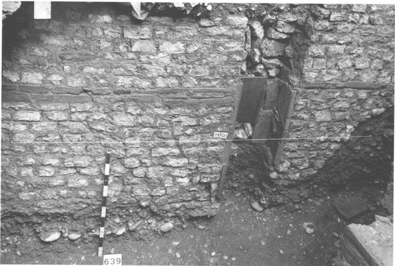
Abb. 10 Augst BL, Grabung 1990.51, Fläche 3. Ansicht der Mauer 5 im vortheaterzeitlichen Keller (Phasen 1 und 2). Zur Lage vgl. Abb. 9.
