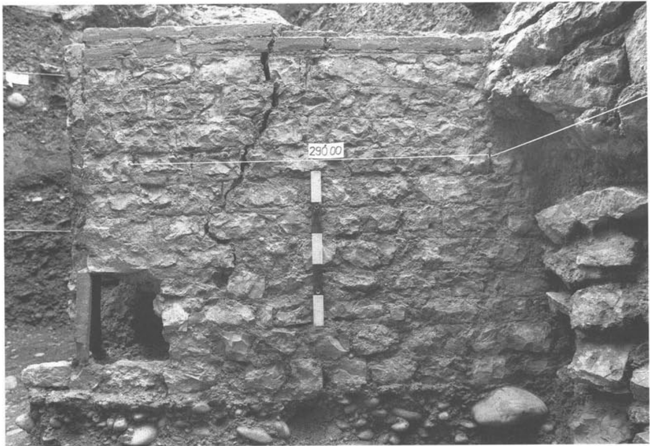
Abb. 12 Augst BL, Grabung 1990.51, Fläche 3. Ansicht der Mauer 12 im vortheaterzeitlichen Keller (Phasen 1 und 2). Rechts im Bild ist das Fundament des in Phase 4 errichteten, an die Mauer 12 anstossenden Strebe Pfeilers 2 (MR 9) des 1. Theaters zu erkennen. Zur Lage vgl. Abb. 9.
