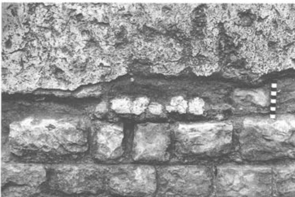
Abb. 68 Augst BL, Grabung 1990.51, Fläche 3. Detail des Verputzes des 2. Theaters an der Umfassungsmauer 3 des 1. bzw. 2. Theaters. Der auf einem schmalen Absatz sitzende Verputzwulst liegt auf derselben Höhenkote wie die bei den Umbauarbeiten in Phase 10 eingebrachte Planie wie resp. der älteste Gehhorizont der Phase 11 (zur Lage vgl. Beilage 1, B.D.F).
